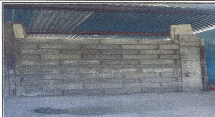
Foto 2: Se evidencia el inicio de rehabilitacion de la division del modulo II
