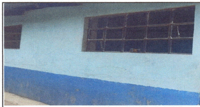
Foto 6: Evidencia del inicio de cambio de ventanas
