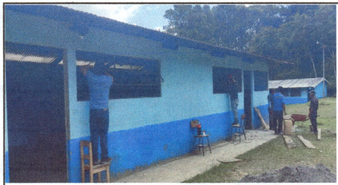
Foto 4: evidencia del inicio de la colocacion de balcones del modulo II
