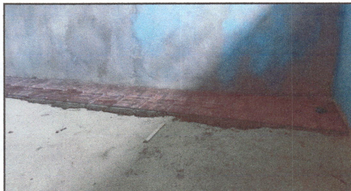
Foto 3: Imagen que evidencia el proceso de sustitucion del piso de torta por piso ceramico.
