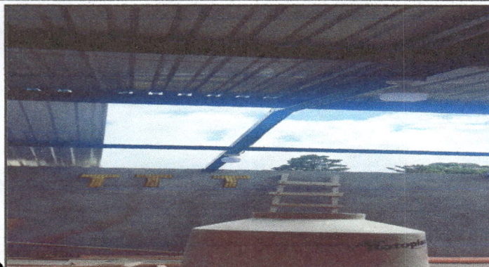
Foto 1: Se evidencia el cambio de entechado y colocacion de laminas del modulo I
